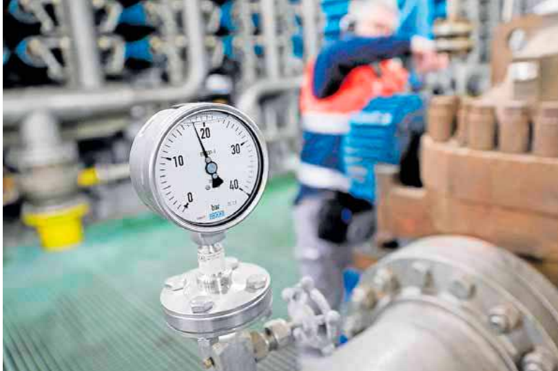
Emasa avanza en el control del suministro de agua potable. MIGUE FERNÁNDEZ
