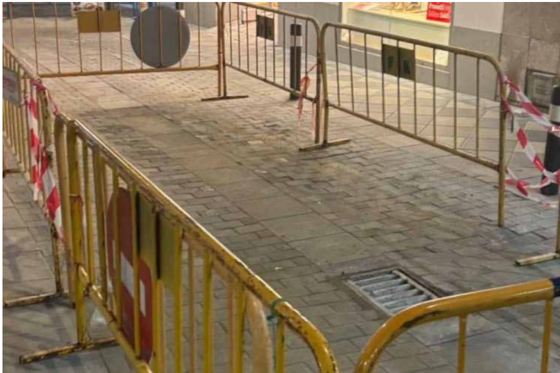
La acera, completamente reparada. / Ayto. Algeciras.
