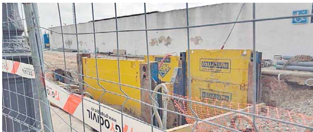
Una imagen de archivo de las obras del tanque de tormentas, en la avenida de la Bajamar.
